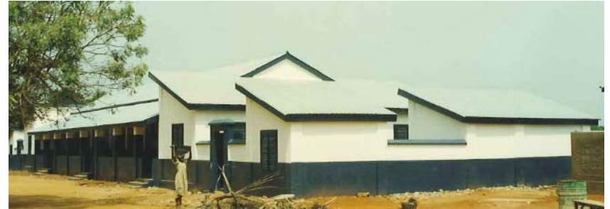
Rénovation d'une école (1949) comprenant les logements des enseignants
